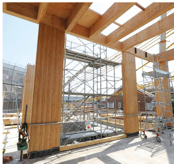
Face.Solidを使用した大学施設: ソリッド状の壁柱で更に自由な空間を実現。CLT、LVL木層ウォール、集成材に対応
