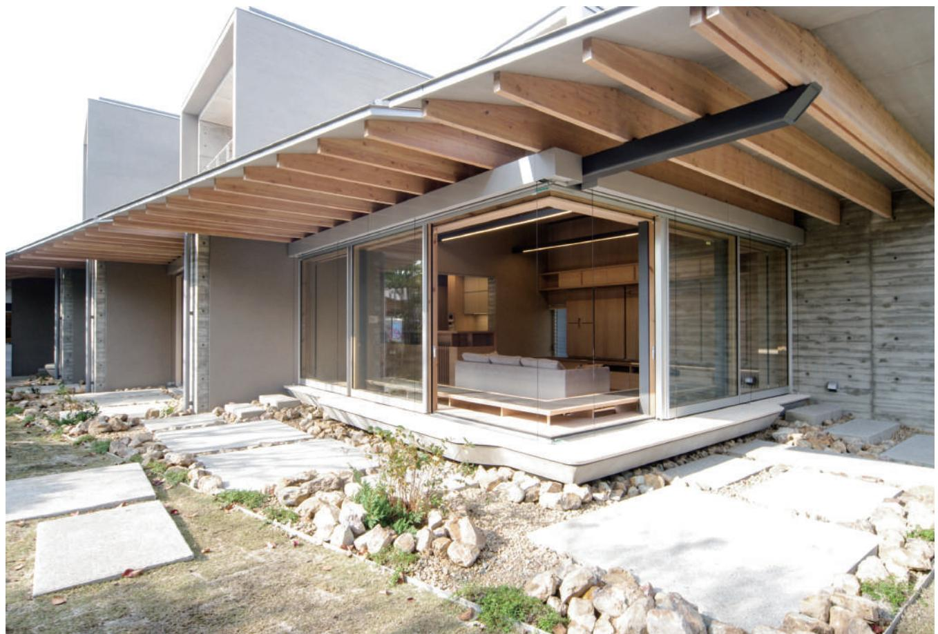
深い庇の木製梁と鉄筋コンクリートの接合にはNode.RCが使用され、あらわしで美しい納まりを実現
